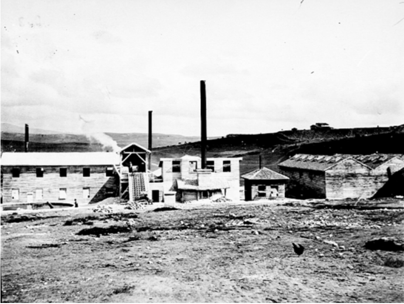
Ek 4: Pandermit ufalama binası
